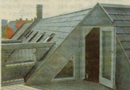
Tagterrassen her på Gl. Kongevej blev bygget i forbindelse med tagrenovering.
